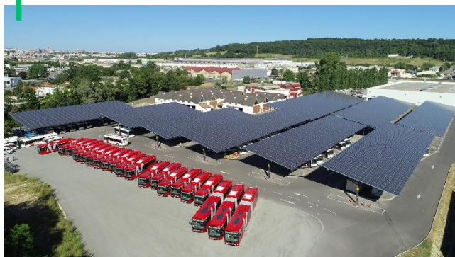
Exemple d'ombrières sur un dépôt de bus (Angoulême).
